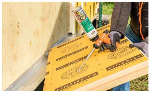
Schritt 2: Anbringen der Dämmung
