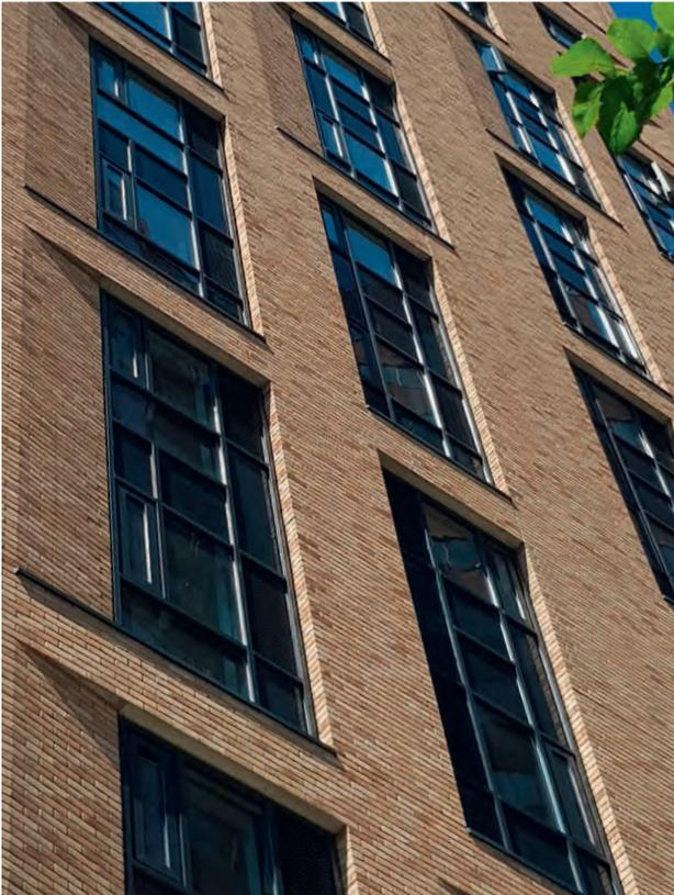
Die einfache und klare Strukturierung des **Läuferverbandes** unterstreicht die besondere Architektur.
