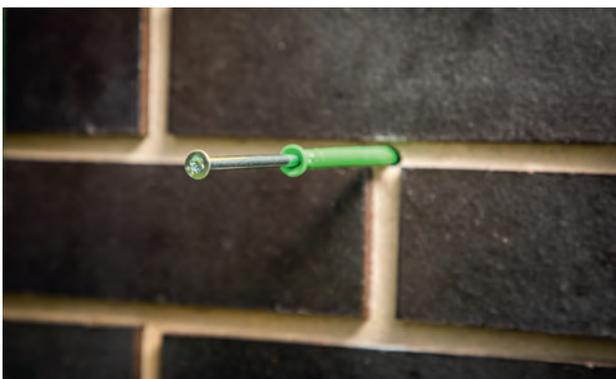
Schritt 6: Anbohren für die Befestigung; passende Dübel und Schrauben setzen
