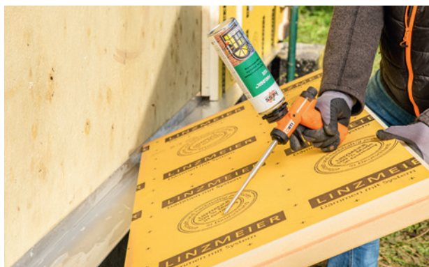
Étape 2 : mise en place de l'isolation supplémentaire
