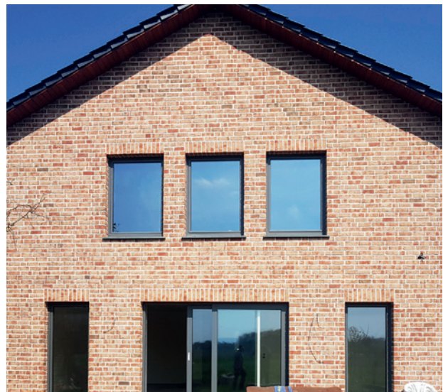
Lorsque les fenêtres sont très proches les unes des autres, une mise en œuvre rapide et efficace est garantie par des éléments en U (trumeaux)
