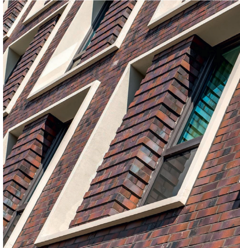
Les embrasures de fenêtre en saillie et crépies forment un beau contraste avec la façade en briques.
