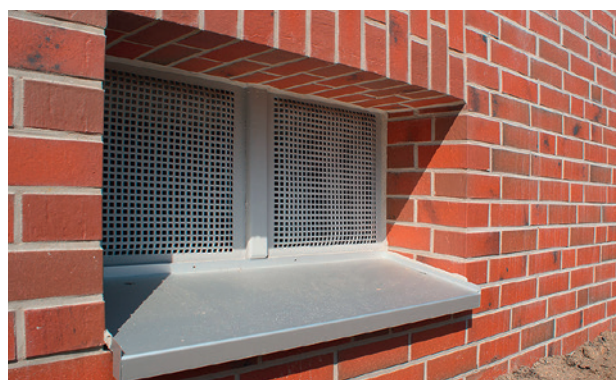
Fensterecken in unterschiedlichen Tiefen
