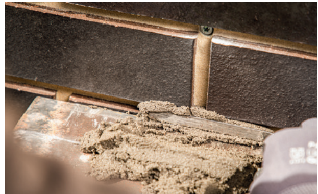
Étape 8 : Jointoiment de la façade en briques
