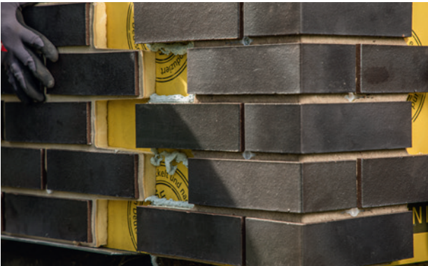
Étape 5 : mise en place simple du panneau Système KESS
