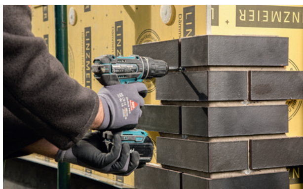
Étape 3 : Pose de l'angle de la maison (collage et vissage)
