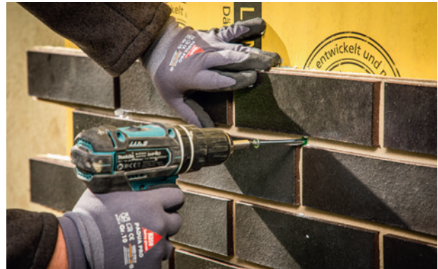
Étape 7 : Fixation des éléments
