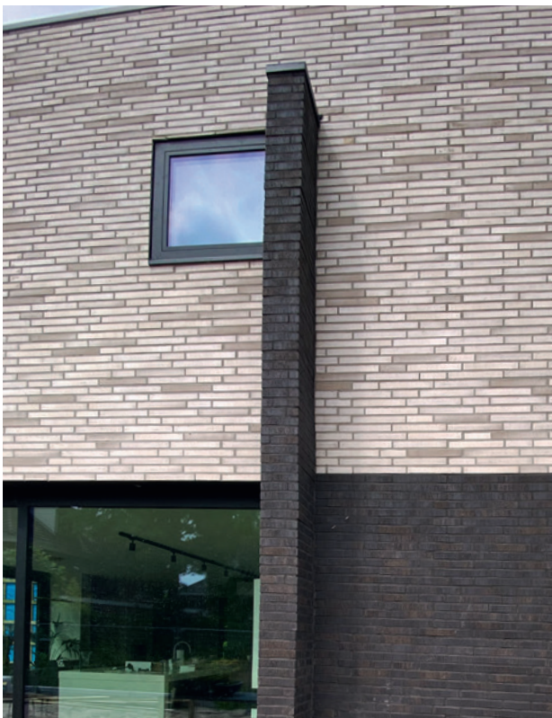
Assemblage sauvage avec des briques grises sur un immeuble de bureaux/d'habitation avec demi-colonne
