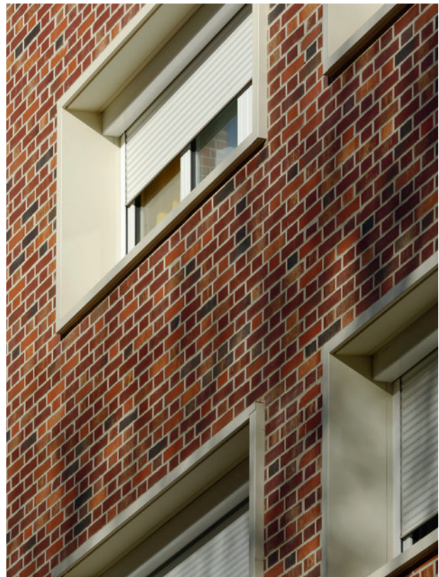
Briques rouges foncées dans l'assemblage flamand.
