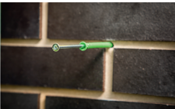
Étape 6 : Percer pour la fixation ; utiliser les chevilles et les vis
