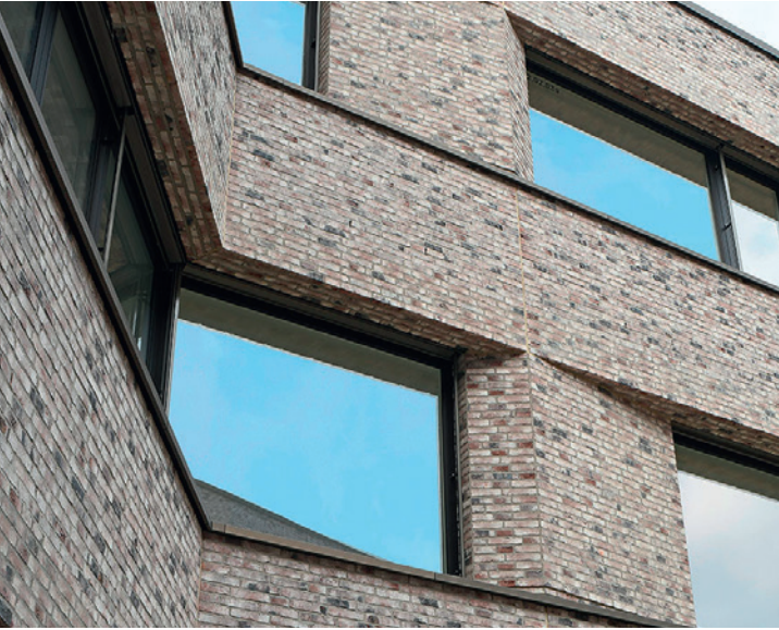
Capez la lumière - le Système KESS a même des solutions pour les embrasures de fenêtres inclinées.
